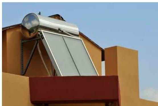
*Figure I.9 : chauffe eau solaire à thermosiphon [24]*
