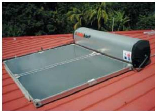
*Figure I .12 : chauffe eau à thermosiphon [3]*
