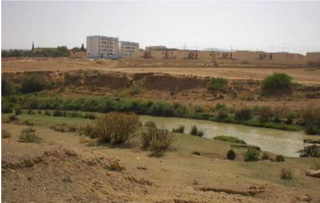
Figure 4.26 Phénomène de glissement de terrain sur la parcelle 2
