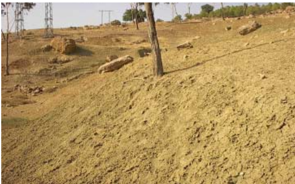
Figure 4.25 Phénomène du glissement de terrain sur la parcelle 1
