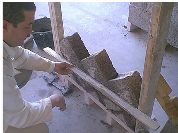
Photo 4.14 Vérification de la planéité avec la règle en bois
