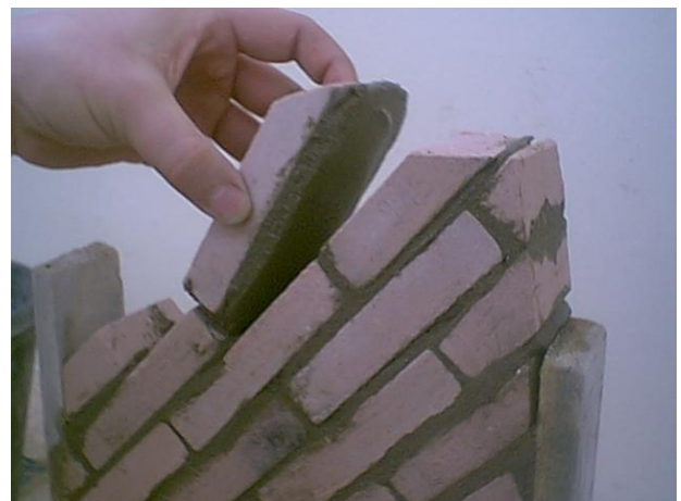
Photo 4.26 Pose de la brique
