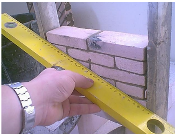
Photo 4.19 Vérification de la planéité
