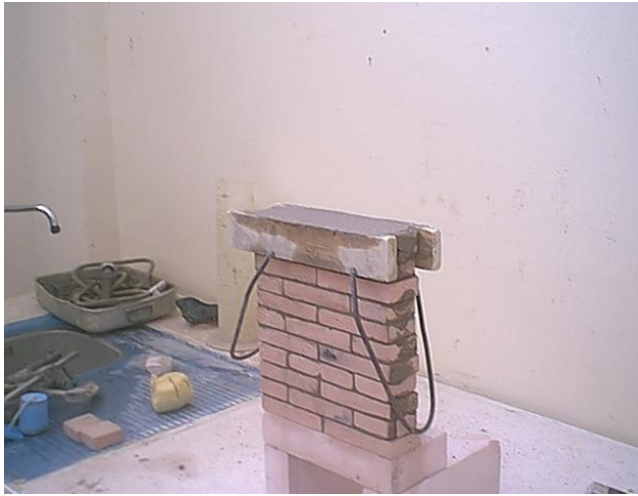
Photo 4.21 Opération de surfacage
