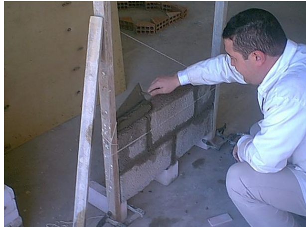
Photo 4.6 Etalement du mortier
