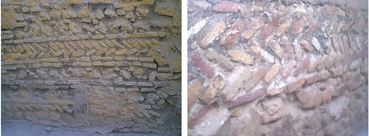
Photo 4.1 Murs en maçonnerie avec une disposition en épi (Médina de Tlemcen)
