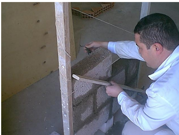
Photo 4.7 Vérification de la planéité du mur avec la règle en bois
