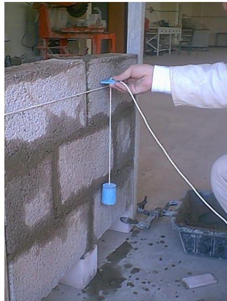
Photo 4.8 Vérification de la planéité du mur avec le fil à plomb
