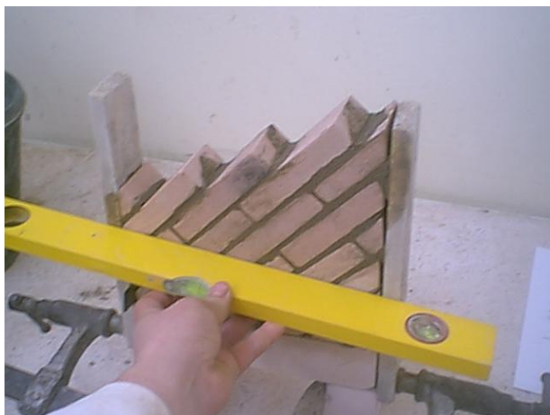
Photo 4.25 Vérification de la planéité du mur
