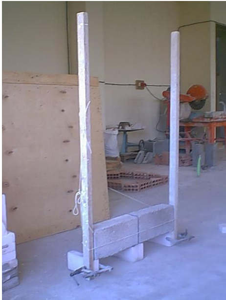
Photo 4.5 Dispositif pour la confection des murets
