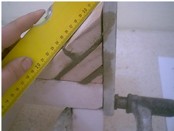
Photo 4.23 Vérification de l'orientation du joint
