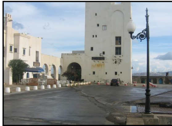
Photo IV- : façade de l'hôtel du Port
