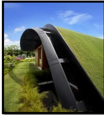
La toiture végétalisée s'installe bien sur une structure en béton ; en acier et en bois
