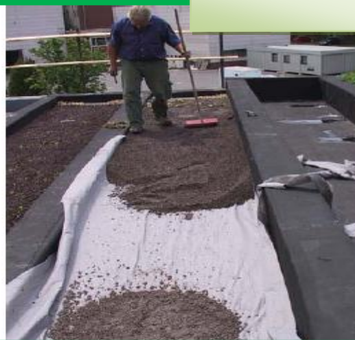
Mise en œuvre du substrat
