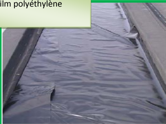
Pose d'un film polyéthylène
