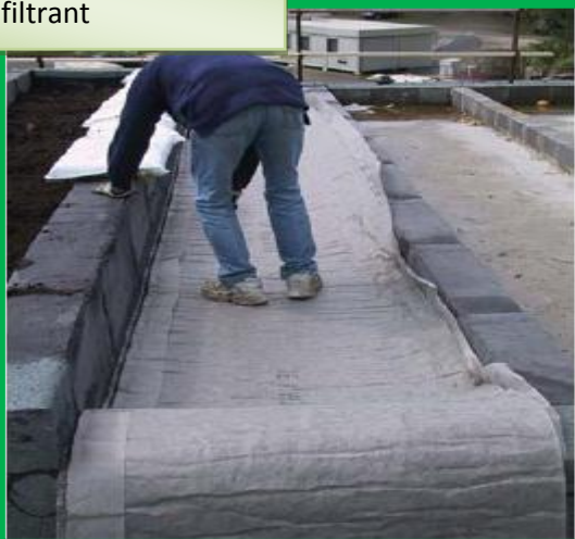
Drainage sous forme de treillis en PE avec voile filtrant
