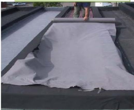
Placement du voile filtrant
