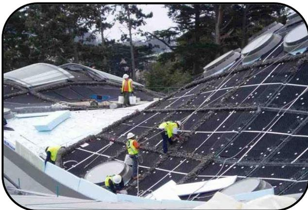
\_ Les panneaux solaires vont générer environ 213,000 Kilowatts/heures d'électricité par an, assez pour couvrir 10% des besoins en énergie de l'Académie
