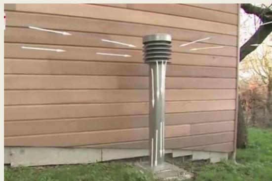
*En été, le sol est à l'inverse plus froid que la température extérieure : ce "puits" astucieux va donc utiliser la fraîcheur relative du sol pour tempérer l'air entrant dans le logement.*
