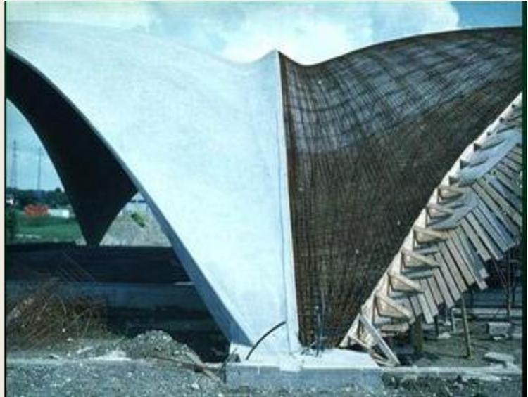
*le problème posé s'énonce ainsi: réaliser une couverture en béton armée ou en métal d'une hauteur limitée ,inscrite en plan dans un triangle de 225 m de coté et ne reposant que sur trois points d'appuis au niveau du sol.*
