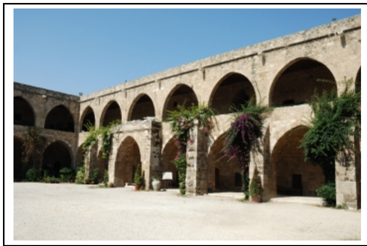
Photo 3 : Fondouk des Francs (Khân al-Franj) à Saida, LIBAN Source qantara patrimoine méditerranéen
