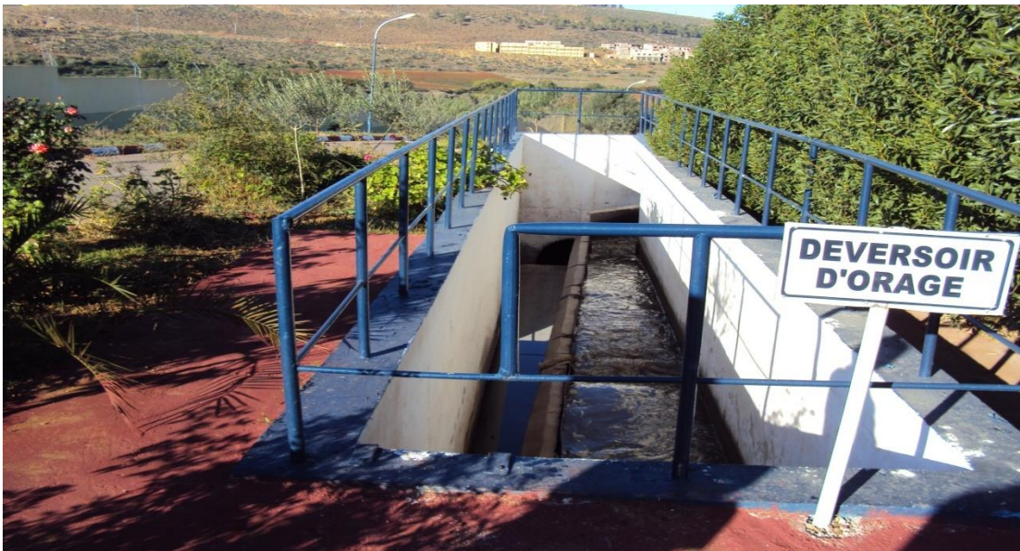
Figure II.2 Déversoir d'orage [2]
