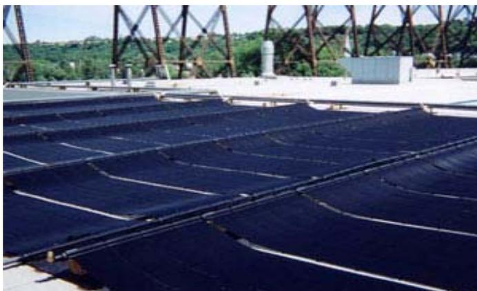
**Fig 3.3 Capteurs solaires plans sans vitrage [5]**
