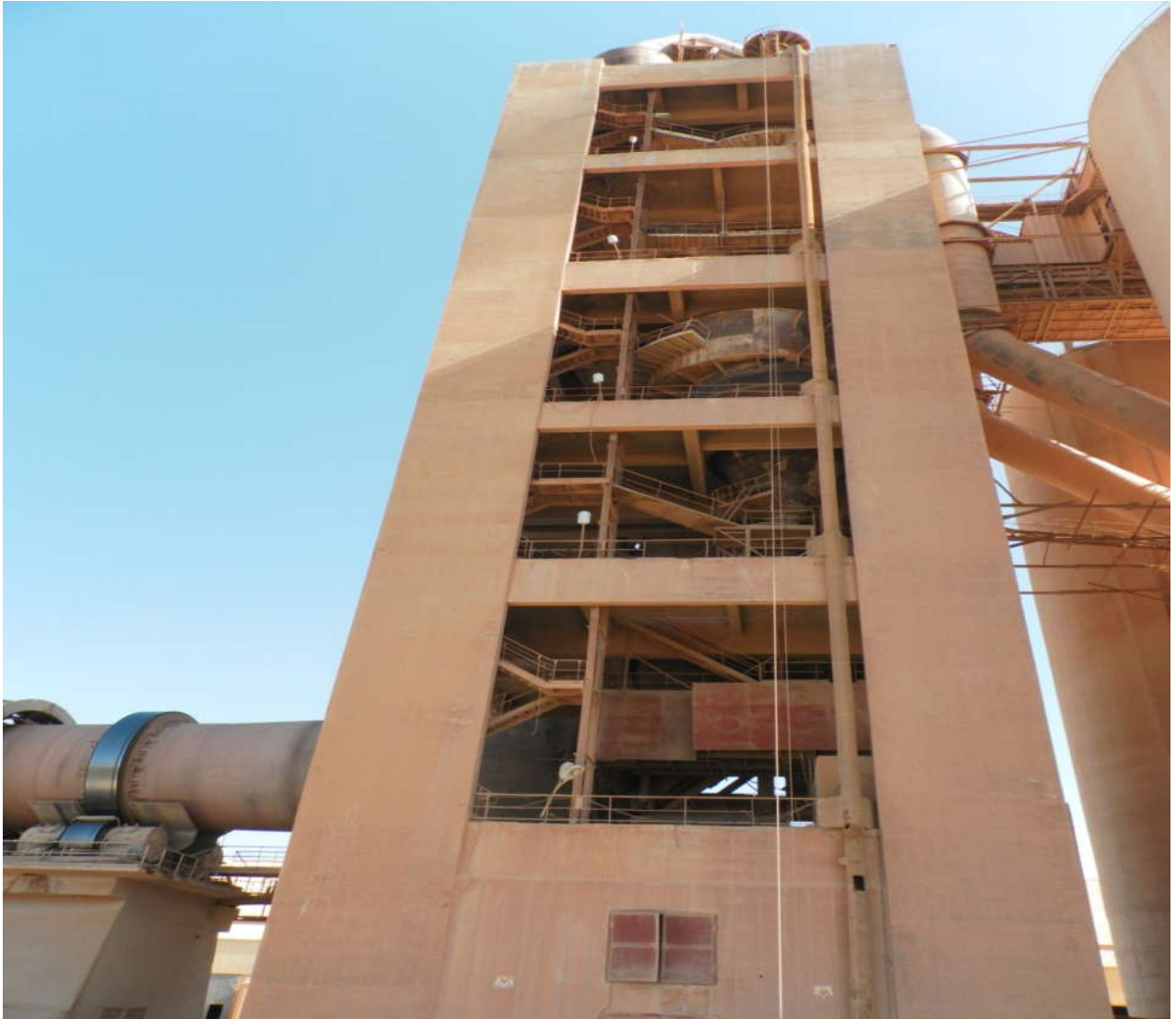
Figure 1.9 : Préchauffeur [23]
