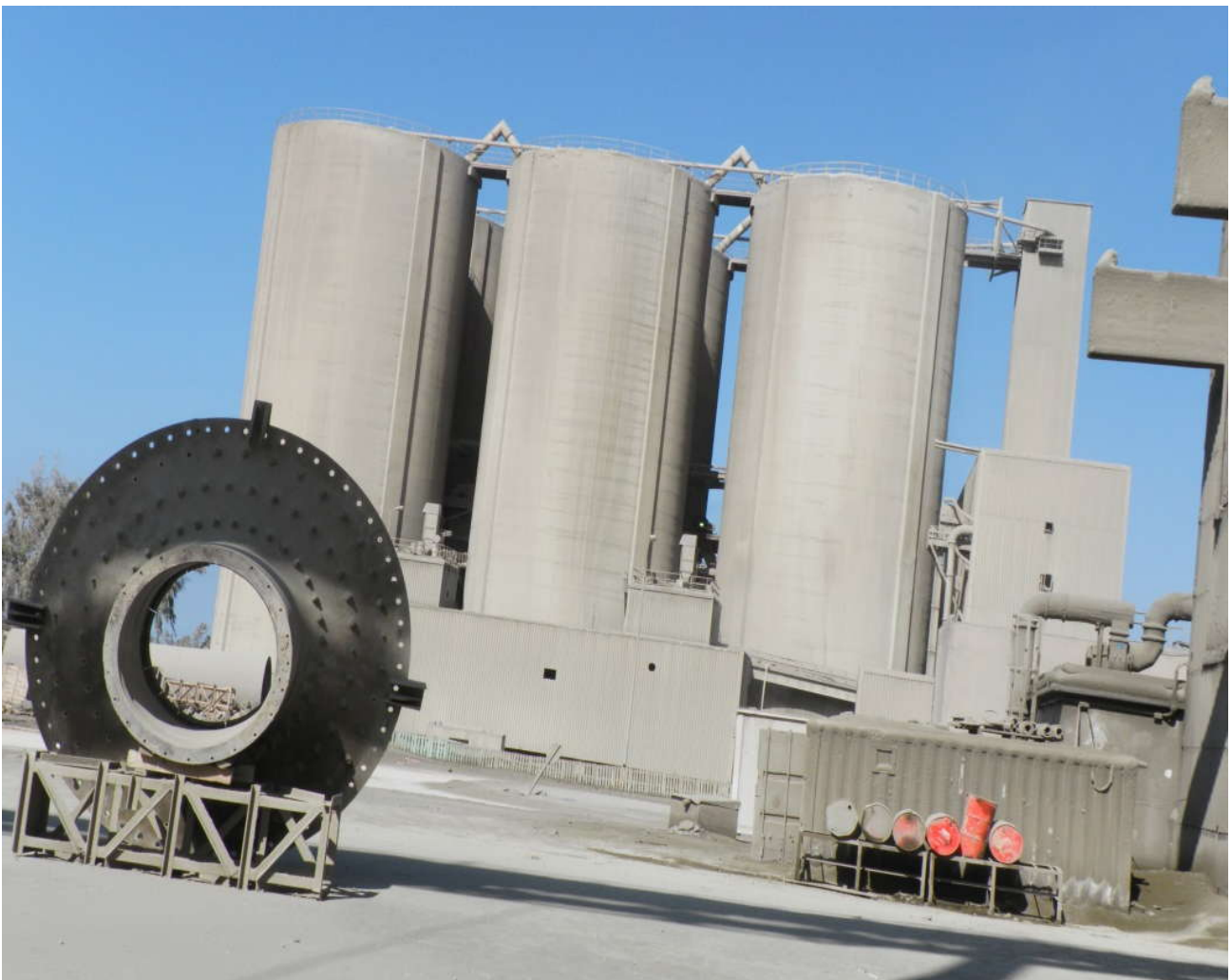
Figure 14 : Silos de stockage de ciment [23]
