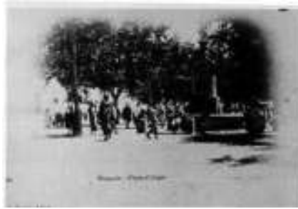
Photo. 3.-Place d'Alger (ex: des Caravanes) probablement entre 1873 et 1875
