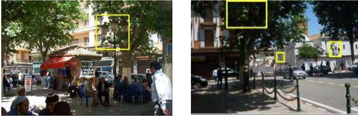
Figure 6- 38: Photographies montrant l'état de l'éclairage urbain Au niveau de la place K.M., source auteur de la présente thèse
