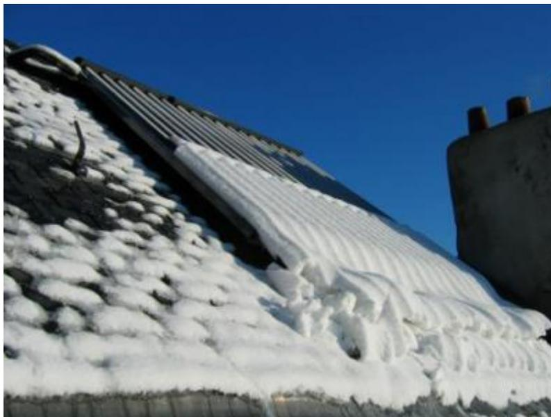
**Figure 1.17 :** Capteur solaire à tube sous vide [17].
