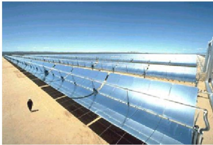
**Figure 1.6 :** Champ de miroir cylindro-parabolique à la centrale solaire de Kramer Junction en Californie. [9]
