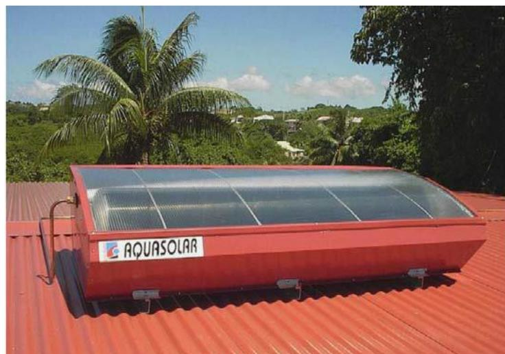
**Figure 2.10 :** Capteur stockeur Aquasolar.
