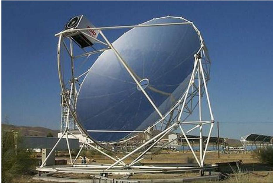
**Figure 1.10** : Miroir parabolique avec moteur Stirling [11]
