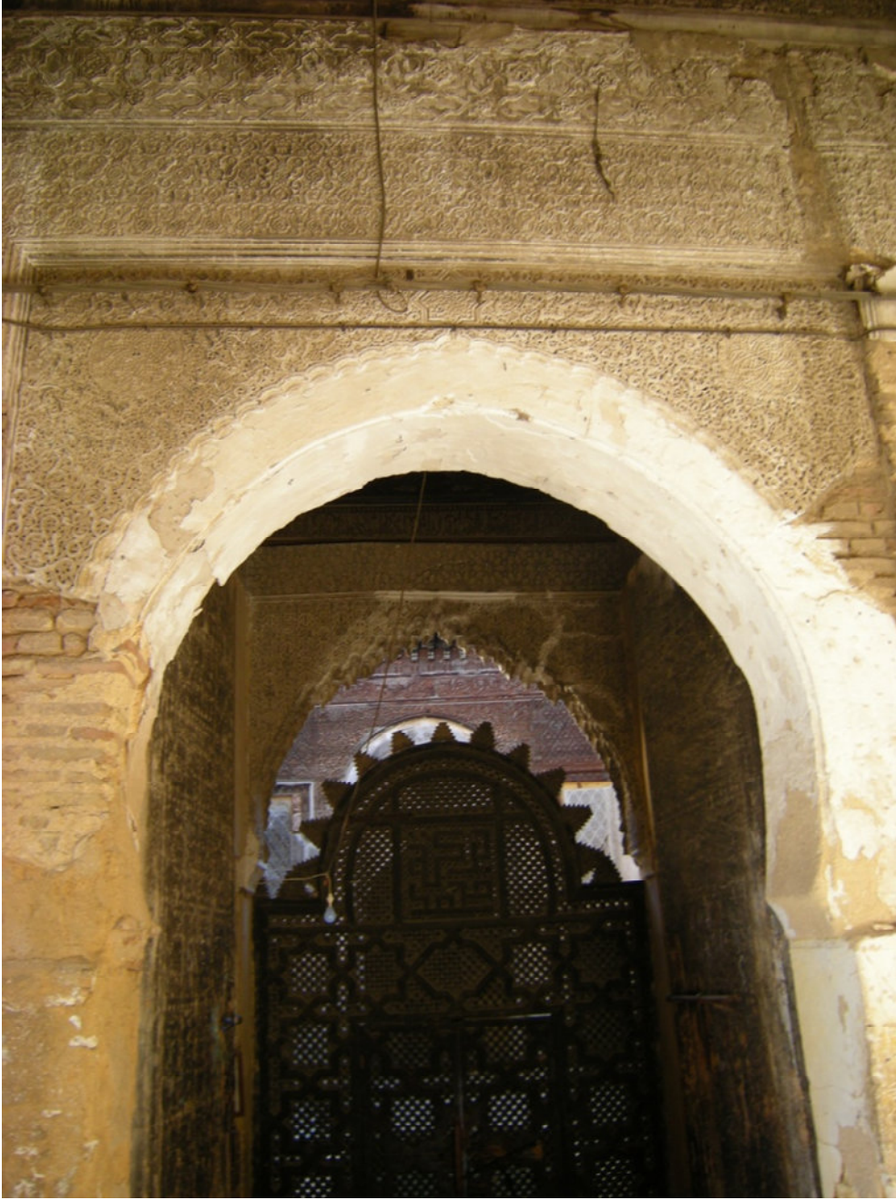
صورة رقم 25 : مدرسة الصّهريج، المدخل
