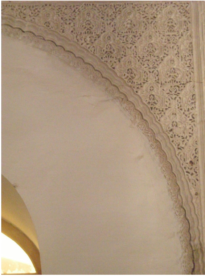
صورة رقم 12: مسجد سيدي أبي الحسن، أحد عقود الجدار الشمالي
