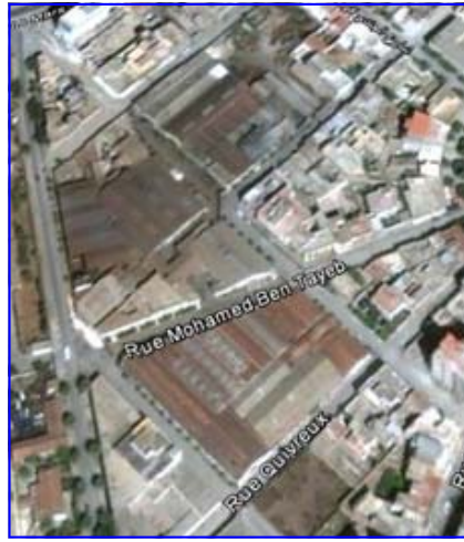
Des studios utilisés comme ateliers sont mal intégrés.
