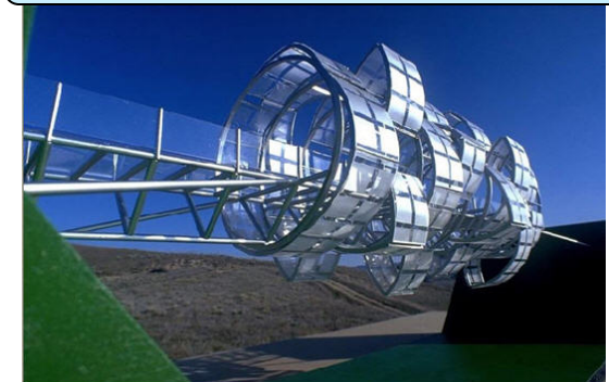
La structure de la passerelle
