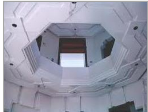
Figure 69: Faux plafond en plâtre.
