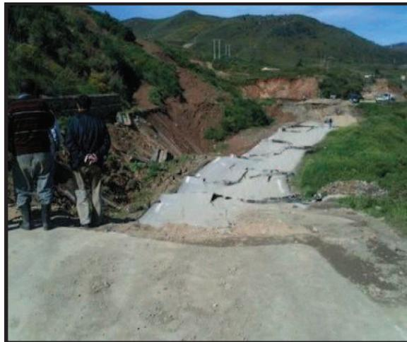
**Figure 2.9** Affaissement routier à Béjaïa en 2012
