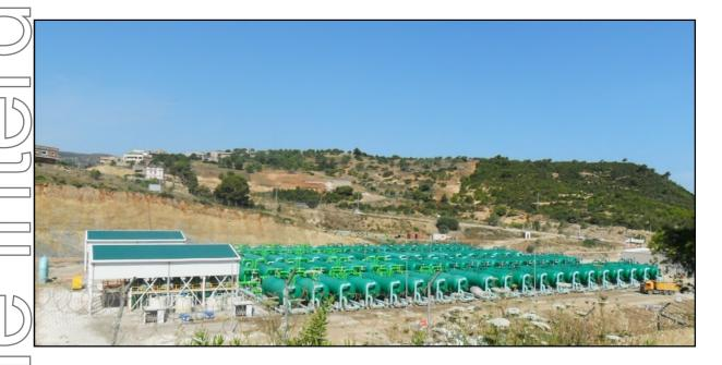
Figure 1.10 Zone de filtration à sable
