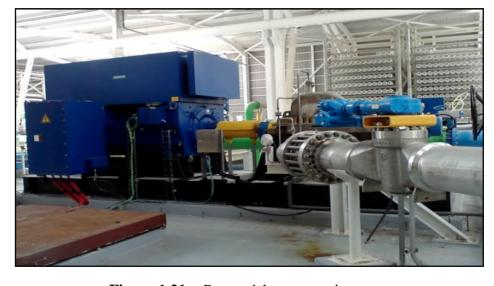
Figure 1.21 Pompe à haute pression
