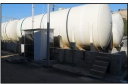
Figure 1.7 Section de dosage d'hypochlorite de sodium (prétraitement)
