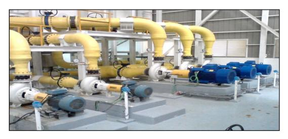
Figure 1.20 Pompes de nettoyage chimique des membranes
