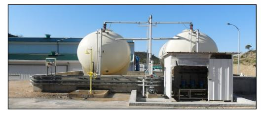
Figure 1.26 Section de dosage d'hypochlorite de sodium (post-traitement)
