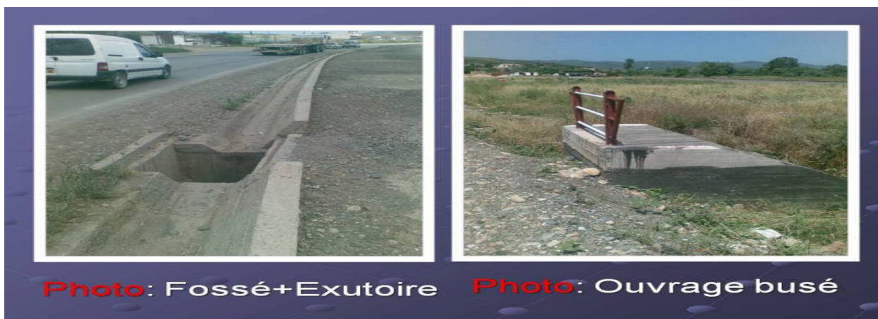
Fig. V.5 : photo fossé+ exutoire et ouvrage bu
