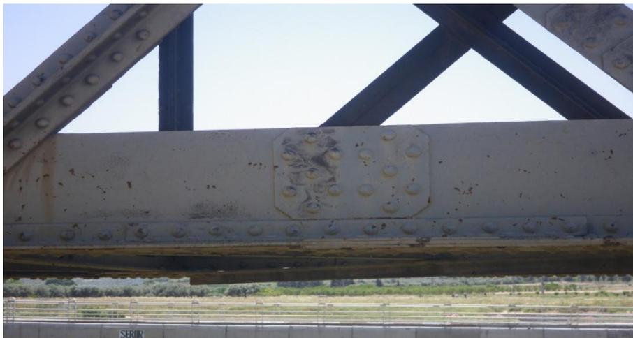
**Photo.7.6-**Assemblage rivet du pont sur Oued Isser
