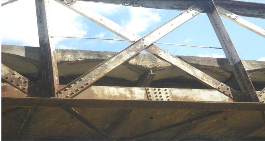
**Photo 7.1-** Etat de corrosion d'un pont sur la RN 22
