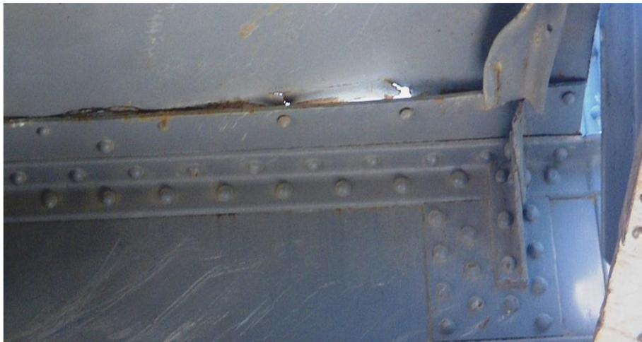
**Photo.7.2** Déconsolidation d'attache rivetée poutrelle-tôle
