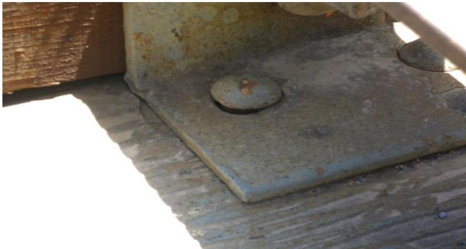
**Photo.7.4** Desserrage d'un rivet au niveau de la tôle du tablier
