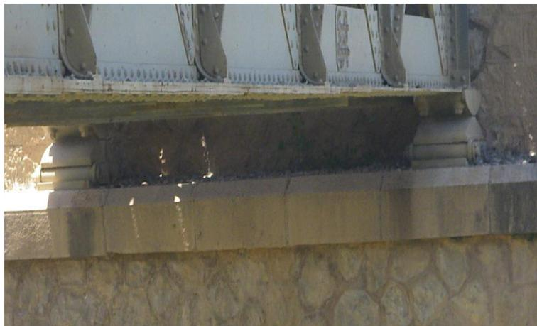
**Photo.3.6** Appareil d'appui simple du pont sur Oued Isser
