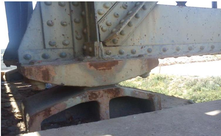
**Photo.3.7** Appareil d'appui double du pont sur Oued Isser
