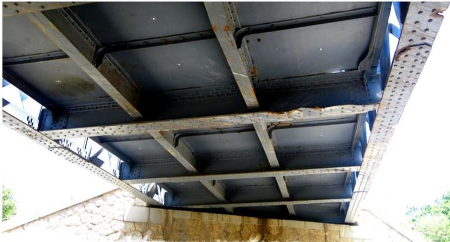
**Photo.7.3** Désordres architecturaux des éléments structurels inférieurs
