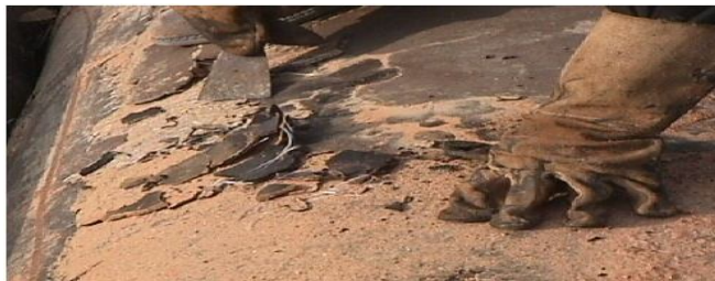
Figure 2.17. Décapage manuel (STT).
