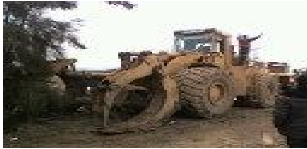
Figure 2.16: Les machines de transports des pipelines (STT).
