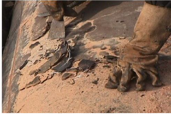
Figure II.4 : décapage manuelle (STT)
