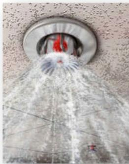
Les extincteurs automatiques sont un autre type d'extincteur qui se déclenche automatiquement lorsqu'il y a un incendie, ils seront placés au niveau des faux-plafonds.
