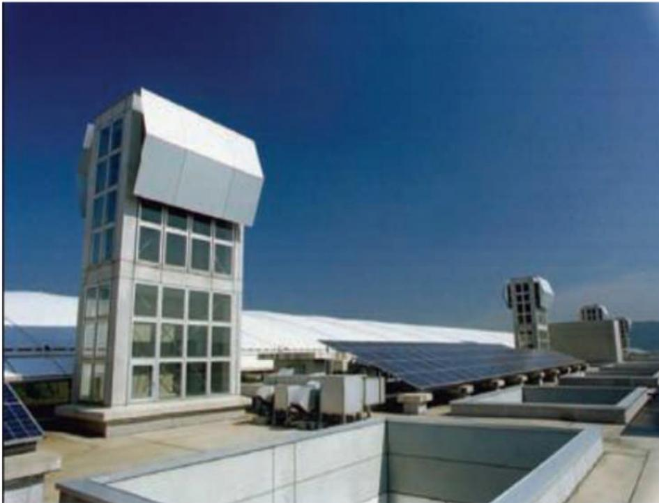
**Figure III.14: Exemple de cheminée solaire intégré sur le bâtiment [21].**
