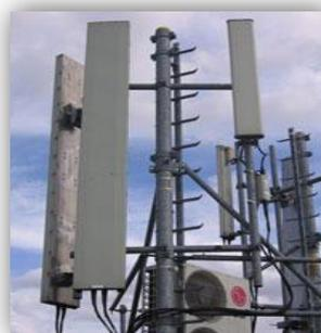
**Figure 1.5 : Exemple d'antennes GSM tri-sectorielles**
