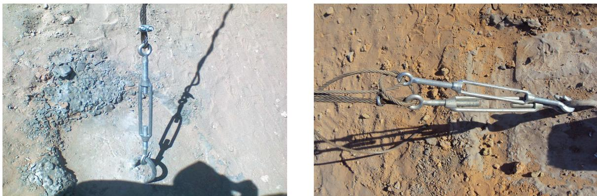
Fig. 16 : Fixation et installation des ancrages et les détendeurs
