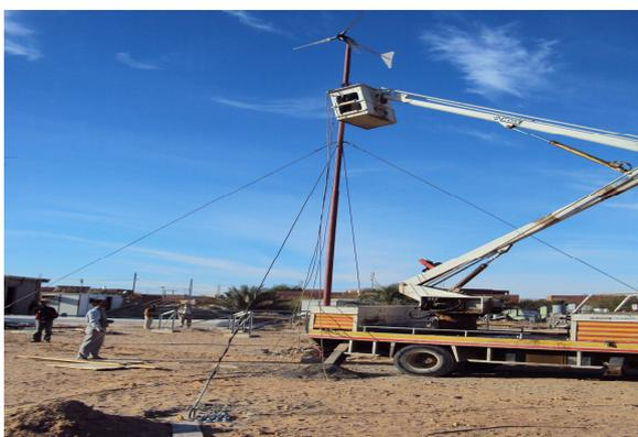
Fig. 19 : Elévation du rotor
