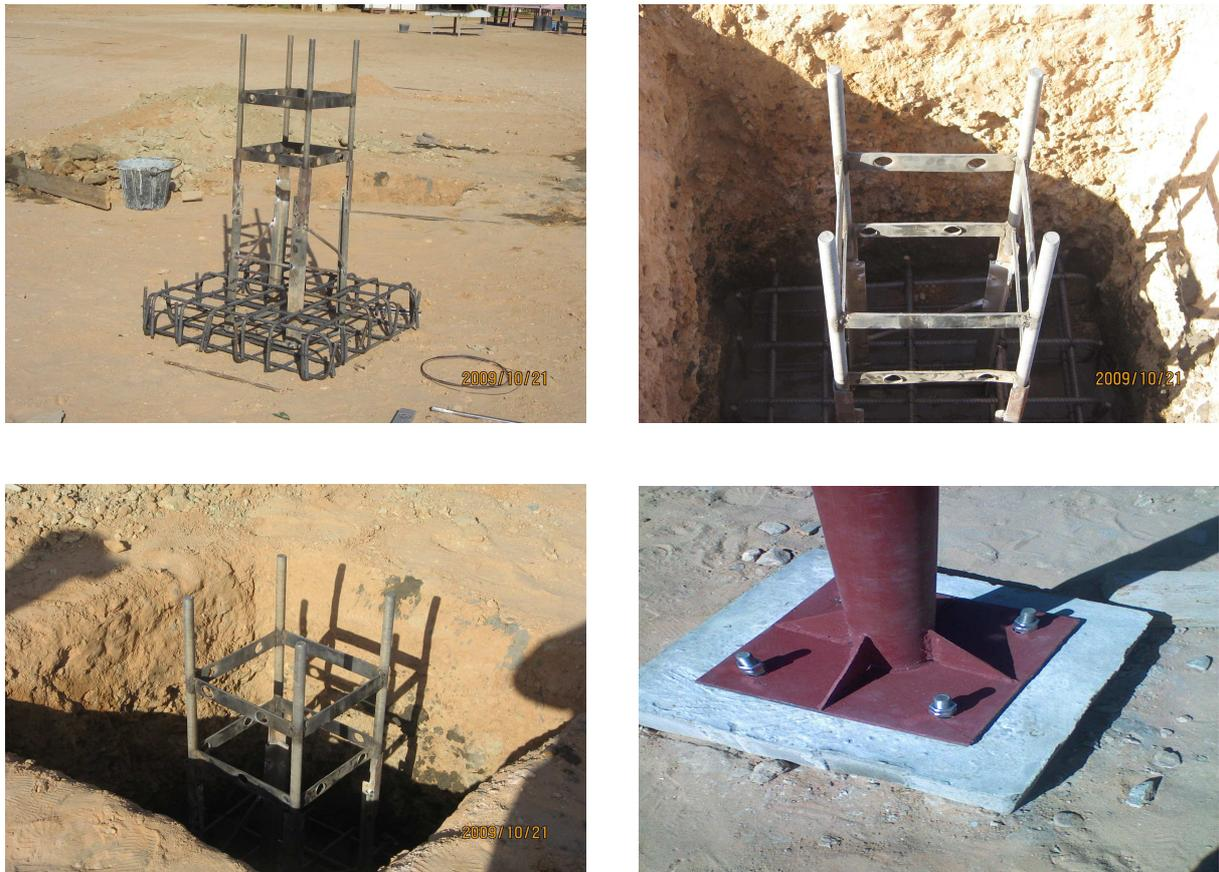
Fig. 15 : Schémas représente les différentes étapes pour la fixation de la base du mât avec le pilier (fondation et Pilier en béton)
