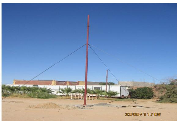
Fig. 18 : Installation du mât sans la turbine
