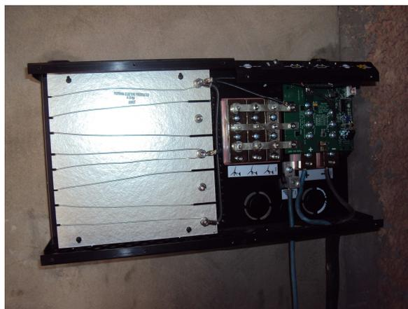
Fig. 21 : Installation du contrôleur Whisper
