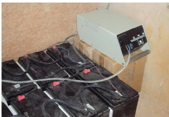
Fig. 22 : Raccordement des batteries avec le convertisseur CP 300
