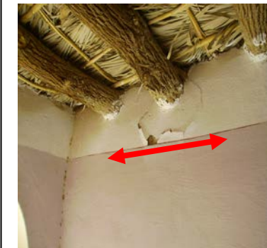
ص(145) تقشر التكسية بعد الترميم
