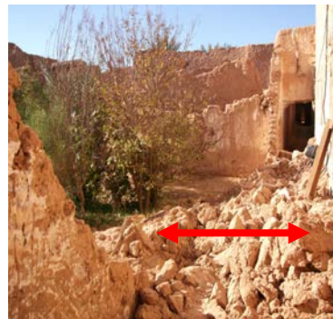
ص(151) سقوط بعض الجدران بقصر قرزيم
