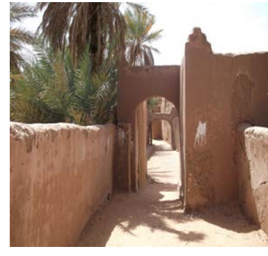
ص(86) المدخل الجنوبي لقصر بني عباس
