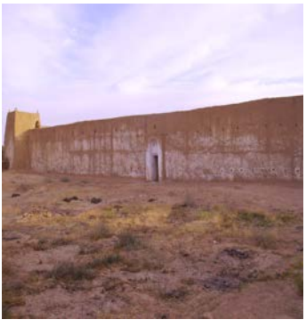
ص(95) الواجهة الأمامية لقصر الواتنة
