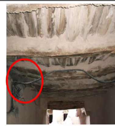
ص(129)خطر تلاقي أسلاك الكهرباء وما ينجر عنه من مساوئ
