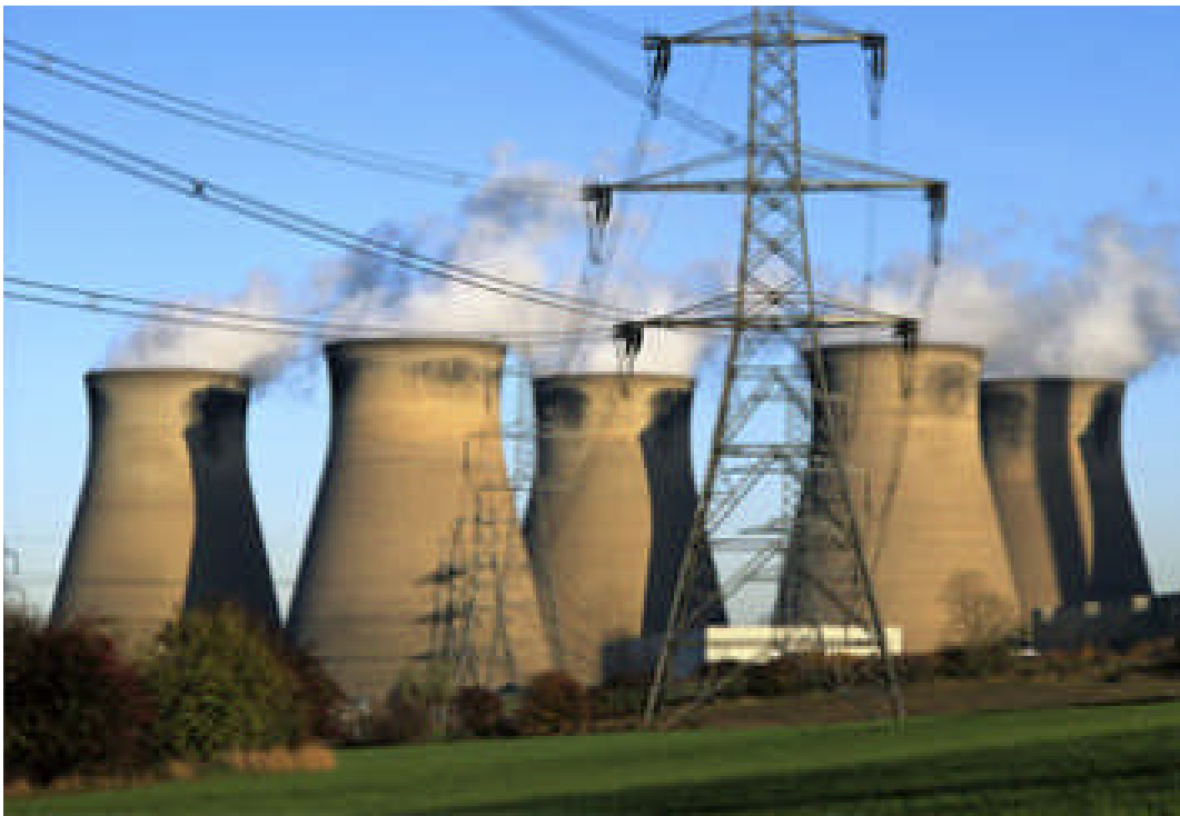
Fig. 2 Centrale nucléaire [S2 (2011)].
