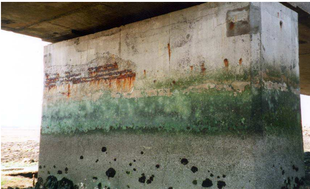
Photo : Pile en zone de marnage
