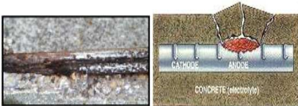
Figure I.11, Dégradation due à la corrosion des armatures [NGU 07]
