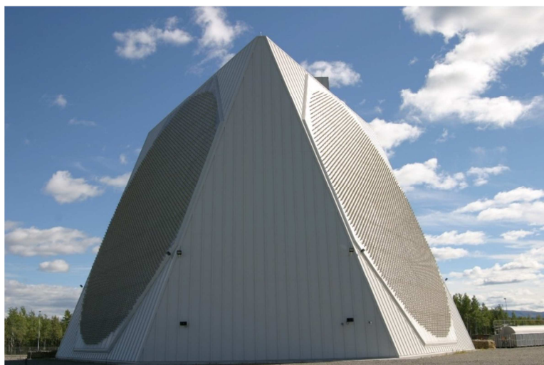
b- radar pour le contrôle des lignes aériennes ( ALASKA USA )
