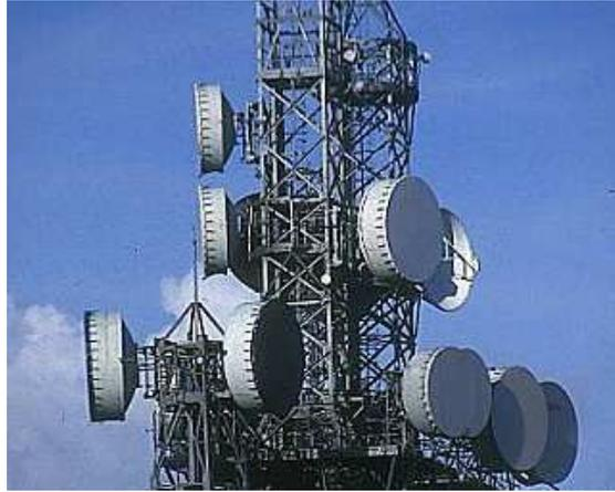
FIGURE 1.1: Exemple d'antennes pour faisceaux hertziens[4].
