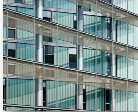
façade sud, détails «peau climatique»
