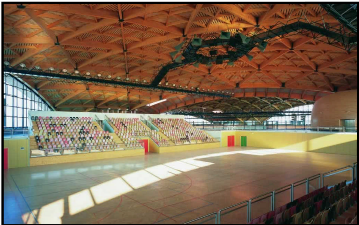
Vue intérieure de la salle omnisport
