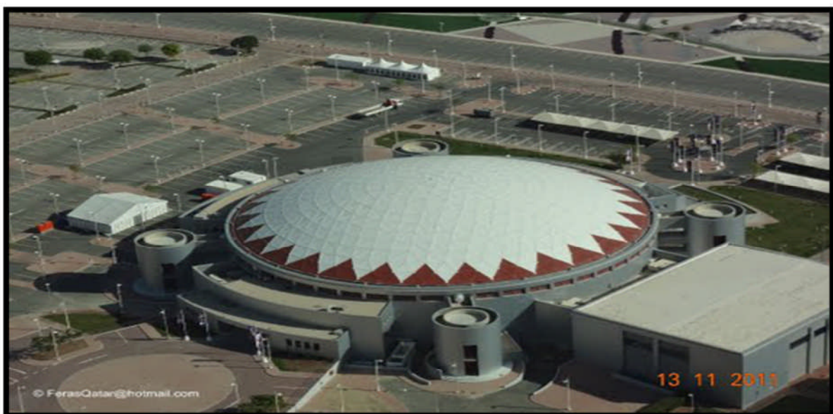
Vue sur la salle de sport (rénovée)
