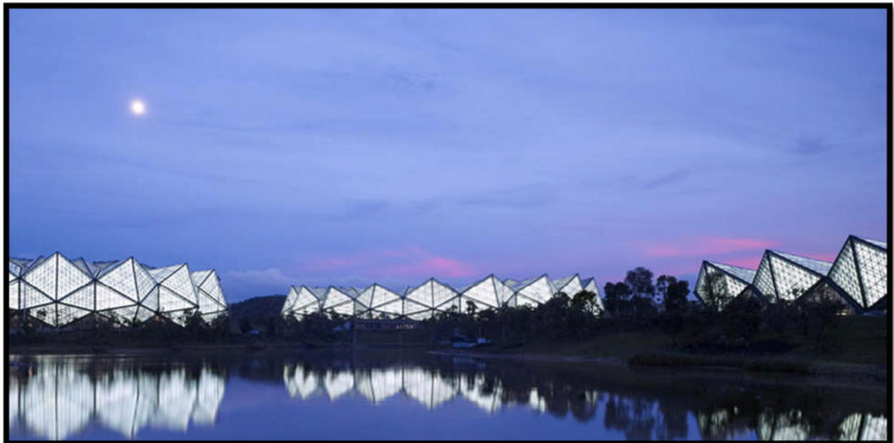
Vue général sur le complexe
