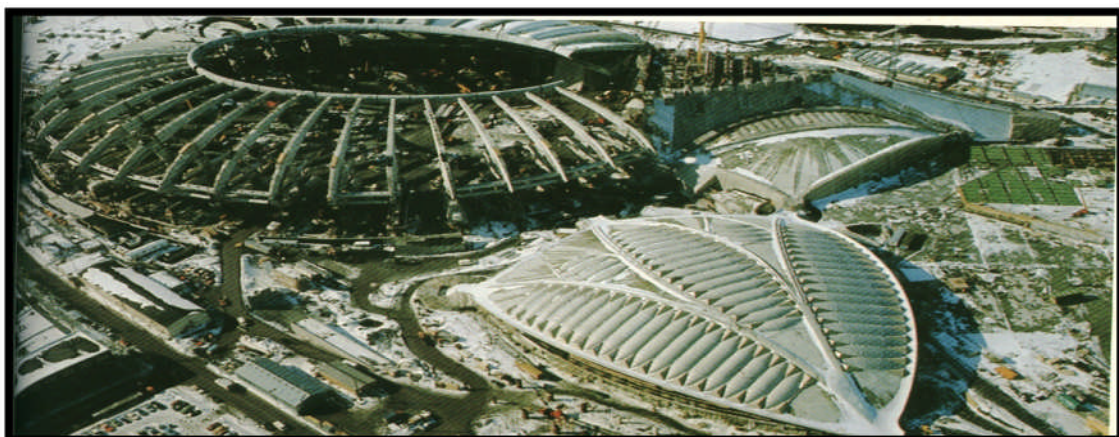
La structure du stade et le palais des sports
