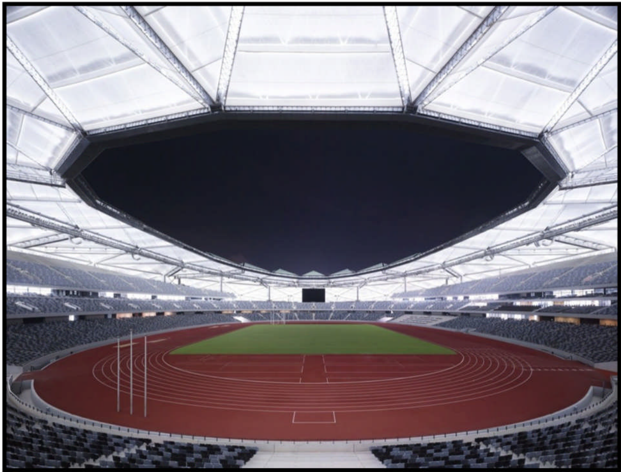
Vue intérieure du stade
