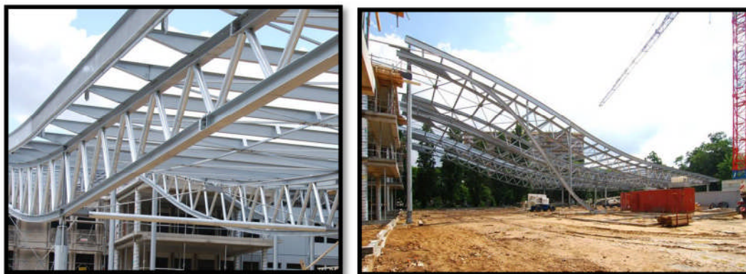
Figure 26: Les poutres en treillis
