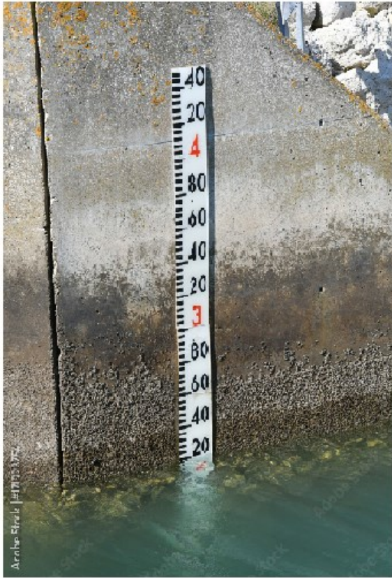
Echelle limnimétrique vertical
