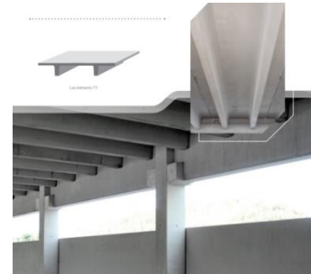
Figure 94: dalle nervurée préfabriquée
