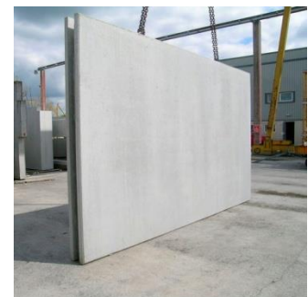
Figure 95: pré mur en béton
