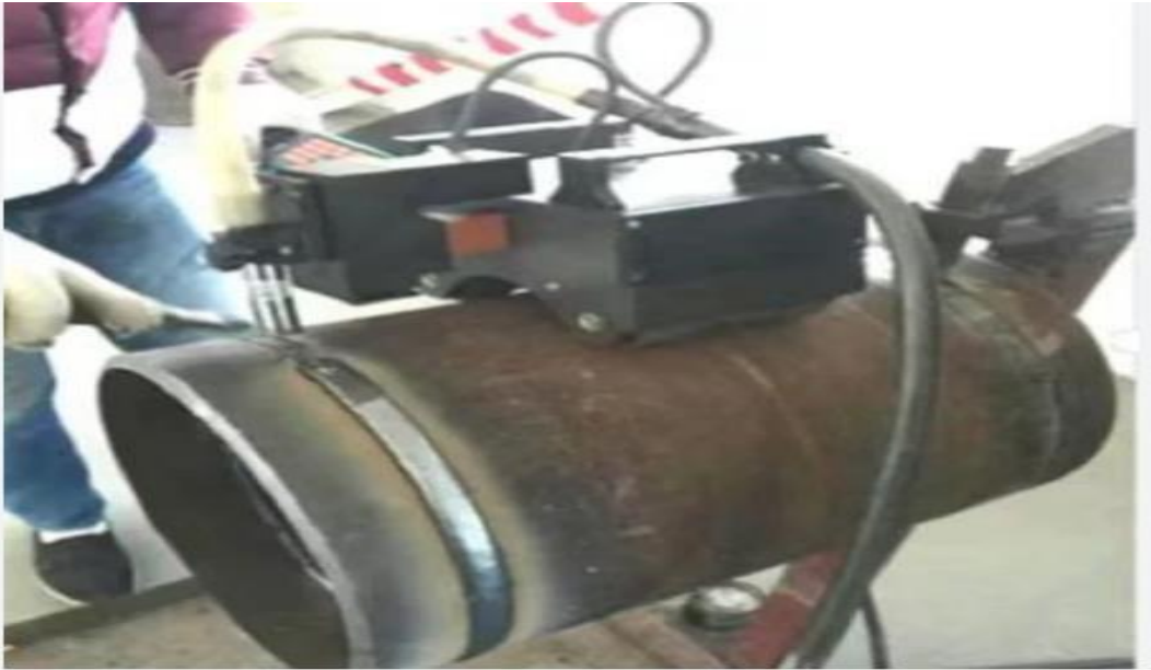
Figure IV.5: Operation de soudage automatique
