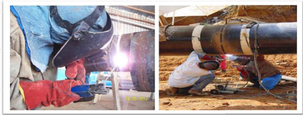
Figure I.3 : Soudage des pipelines (type manuel).
