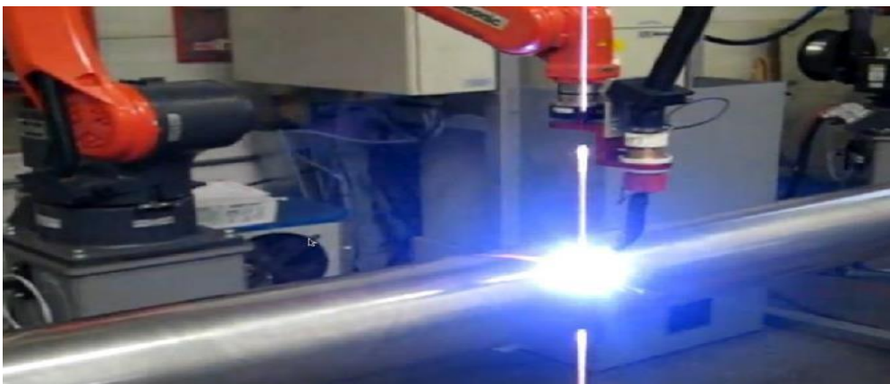
Figure I.6 : Soudage des pipelines type automatique.
