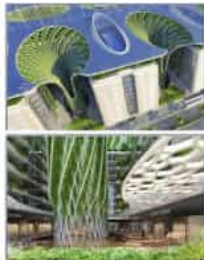
Figure 115 : Les attrape-vent de the gate heliopolis / Source :
