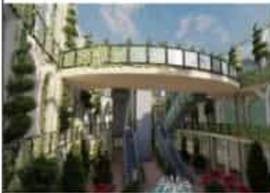
Un courant d'air se crée entre la verrière et les portes-fenêtres
