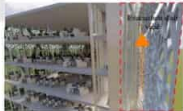
Evacuation d'air vicié par effet cheminée
