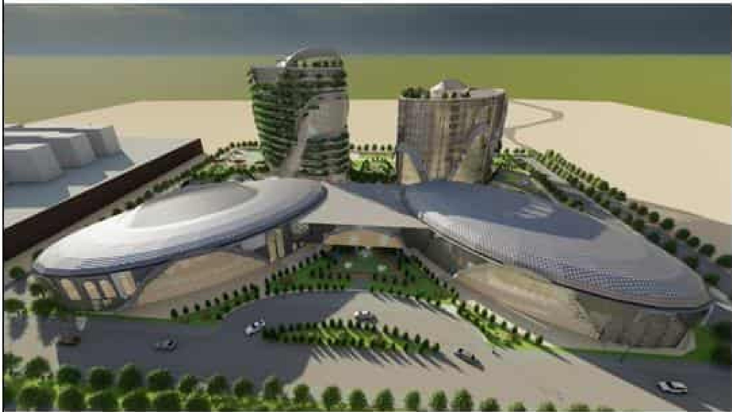
Vue sur façade ouest : Accès principal
