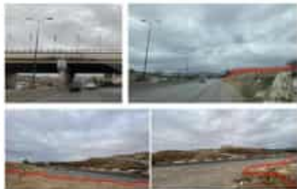
Figure 64 : Terrain d'intervention / source : auteur
