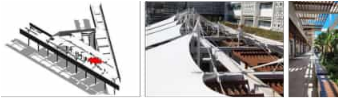
Figure 138 : La toiture en toile du centre commercial d'Arribat center / Source :
