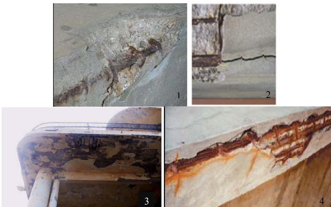
Figure 1. 14 Exemples de corrosion par carbonatation et d'éclatement de béton d'enrobage [(1) et (2) source [http://fr.wikipedia.org/wiki/Fichier:Betonrot\\_Hippodroom.JPG](http://fr.wikipedia.org/wiki/Fichier:Betonrot_Hippodroom.JPG), (3) et (4) Dak, 2009]
