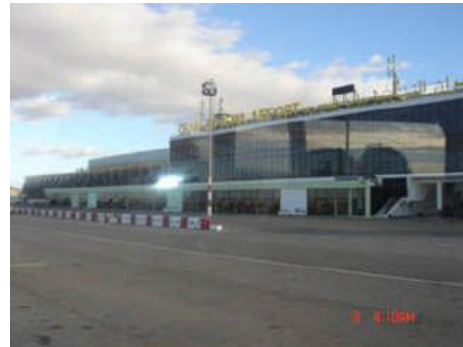
Photo : réseau aéroportuaire
