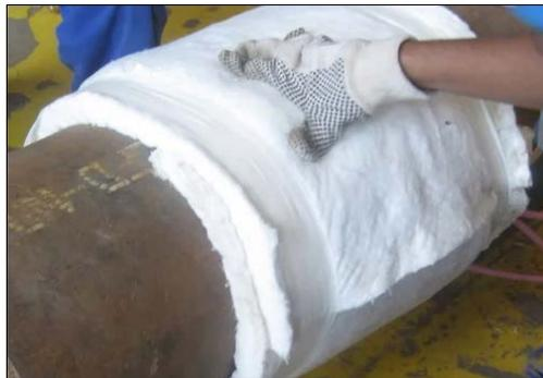
**Figure II.11:** Application de la couverture chauffante. [15]
