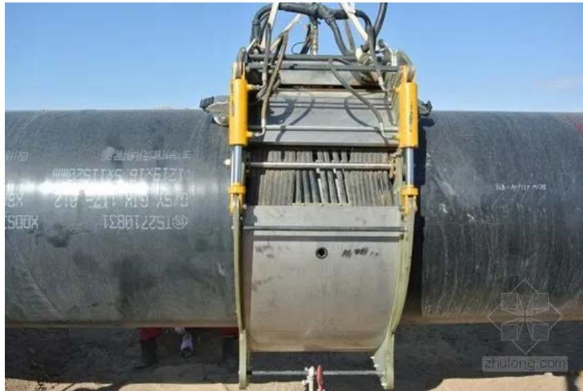
Figure II.9 : Préchauffage par induction. [15]
