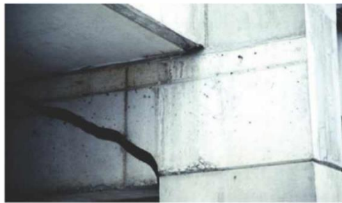
Figure I-6 : Rupture en cisaillement d'une poutre [17] .
