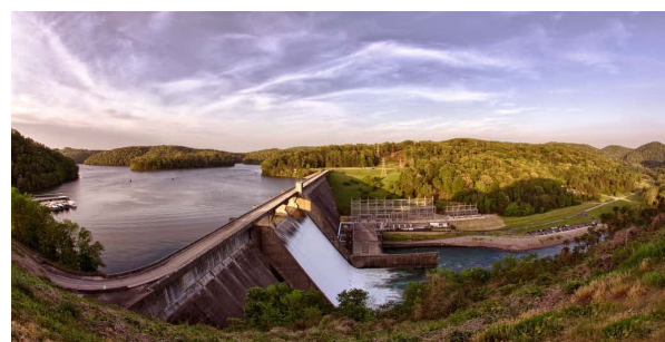
Figure I.16. Barrage poids BCV (Norris, USA)
