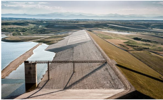
Figure I.6. Barrage en terre homogène
