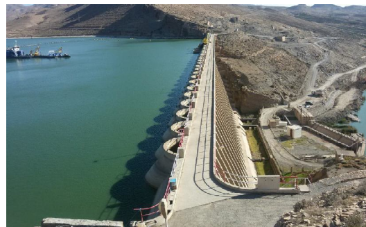
Figure I.22. Barrage à contreforts (Ksob, Algérie)
