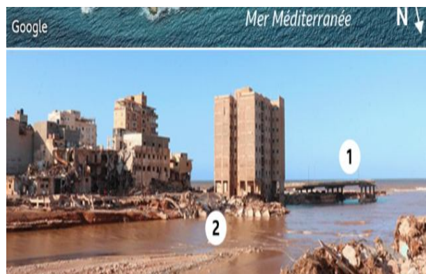
Figure I.4. Ampleur des dégâts - Rupture du barrage Derna en Lybie
