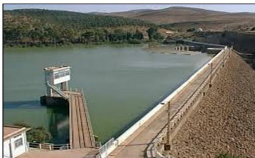
Figure I.12. Barrage en enrochements
