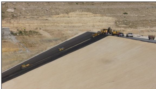
Figure I.10. Barrage à masque amont
