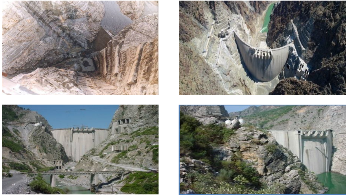
Figure III.1. Géologie typique de faisabilité des barrages voûtes
