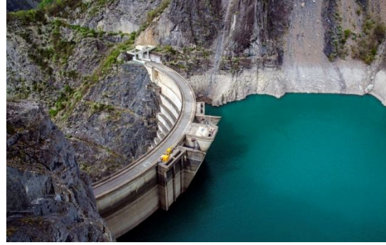
Figure I.20. Photos d'un barrage poids voûte
