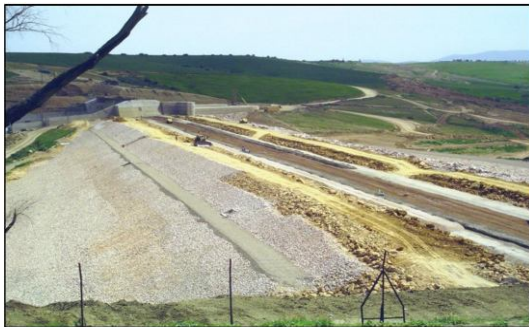
Figure I.8. Barrage zoné à noyau central
