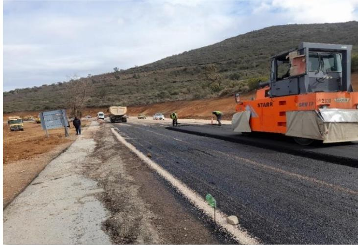
**Photo III-13. Compactage de bitume (17 mars 2024 prise par la DTP Tlemcen)**
