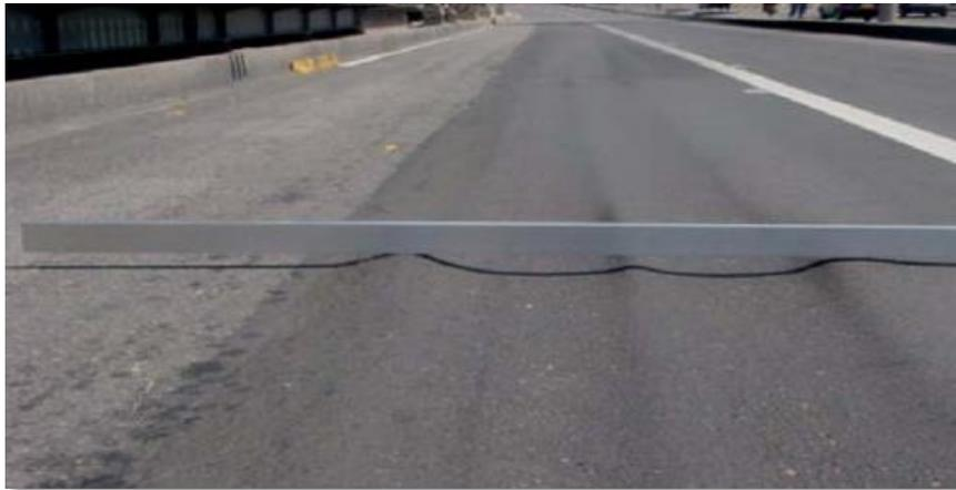
Figure II-2. Cas de dégradation d'une chaussée bitumineuse (comité français de mécanique des sols et de géotechnique, juin 2023)
