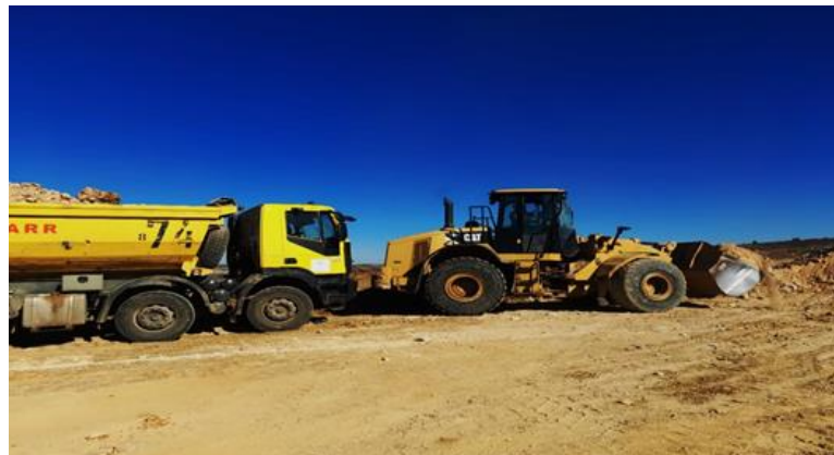
Photo 3.1 Projet de Terny (Décembre 2022 Photo prise par la DTP de Tlemcen).
