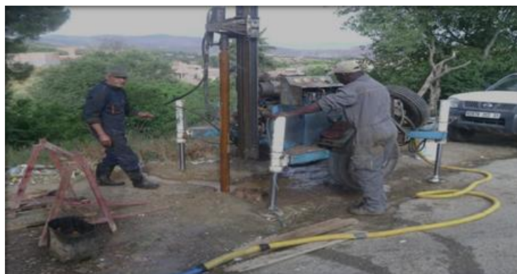
Photo 3.7. Opération de sondage premier Point (La DTP Tlemcen).
