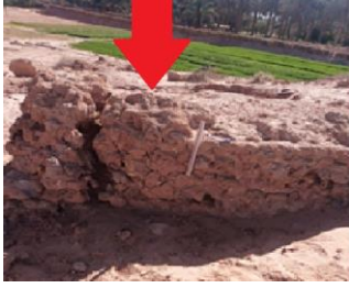
ت. تقنية الكامنتكيوم بحصن واد بومليح، عن عريج نجم الدين، ديسمبر 2021م.
