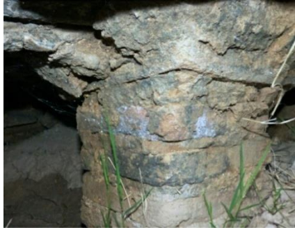
ث. عمود من الاجر تحت الحوض تستعمل بتقنية تسخين الهيبوكوست عن محمد مصطفى، فيلاح، ودبش، سعيد،
