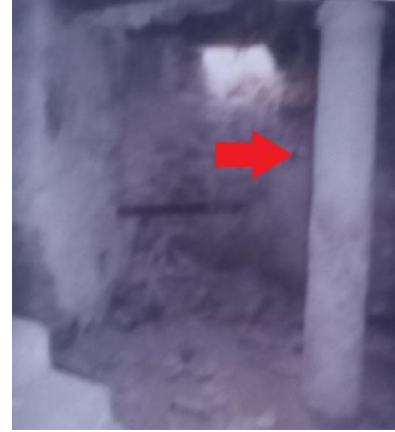
أ. جذع عمود تم إعادة استعماله في بناء منازل الطوب في دشرة فرفار، عن: Samira,haoui,bensaada,2019-2020, p.212,photographie 181.
