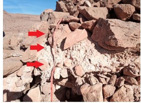
أ. الملاط المستخدم في بناء البازينا، عن عريج نجم الدين، ديسمبر 2020م.
