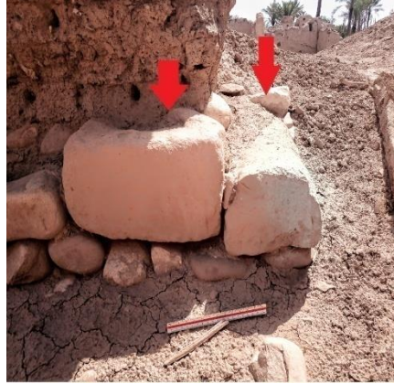
ب. حجارة منحوتة تم استغلالها كأساسات لبناء منازل الطوب في الدشرة القديمة لقرطة، عن: عريج نجم الدين، جويلية 2022م.
