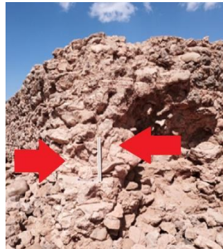
ج. تقنية الكمنتيكيوم في جدران المسكن الجنوبي الغربي في منطقة المرموثة، عن عريج نجم الدين، ديسمبر 2021م.
