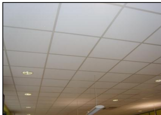
Figure 59: faux plafond vue d'intérieur
