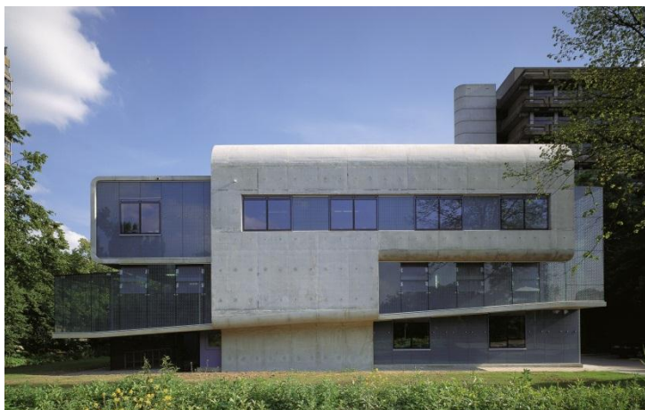
Figure 17: Vue sur façade latérale.
