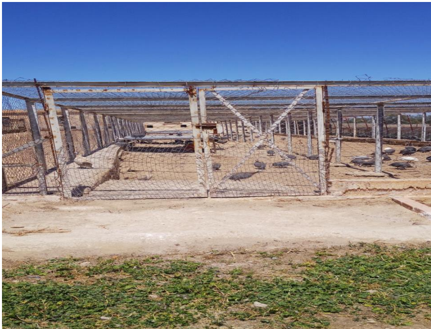
Figure 13 : Bâtiment d'élevage ( www.researchgate.net )
