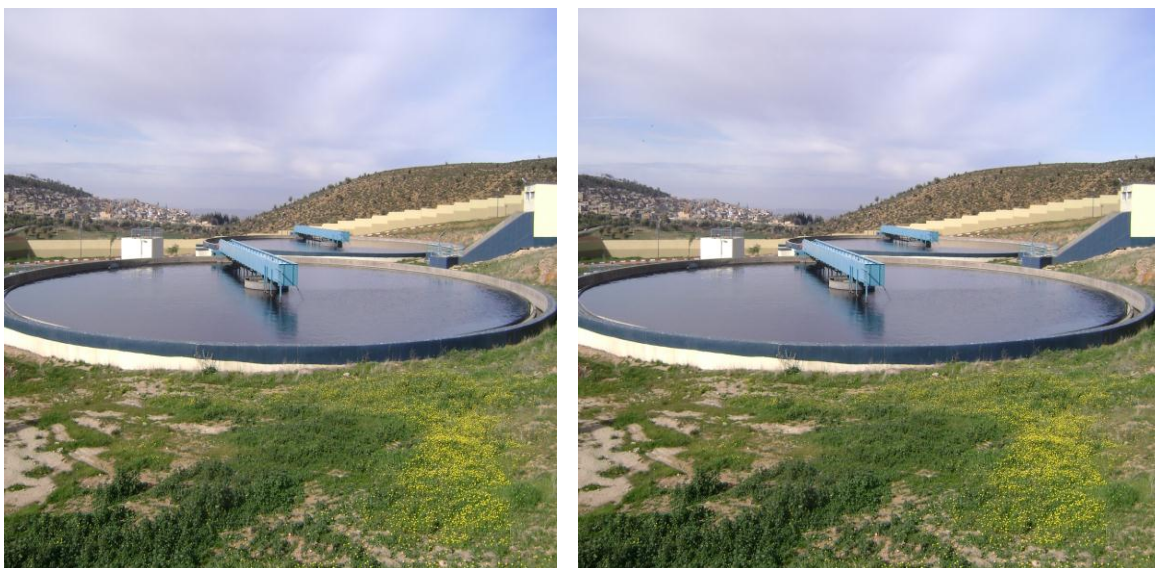
Figure 11 : Clarificateurs
