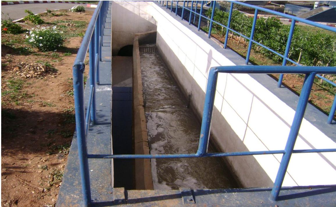
Figure 06 : Déversoir d'orage
