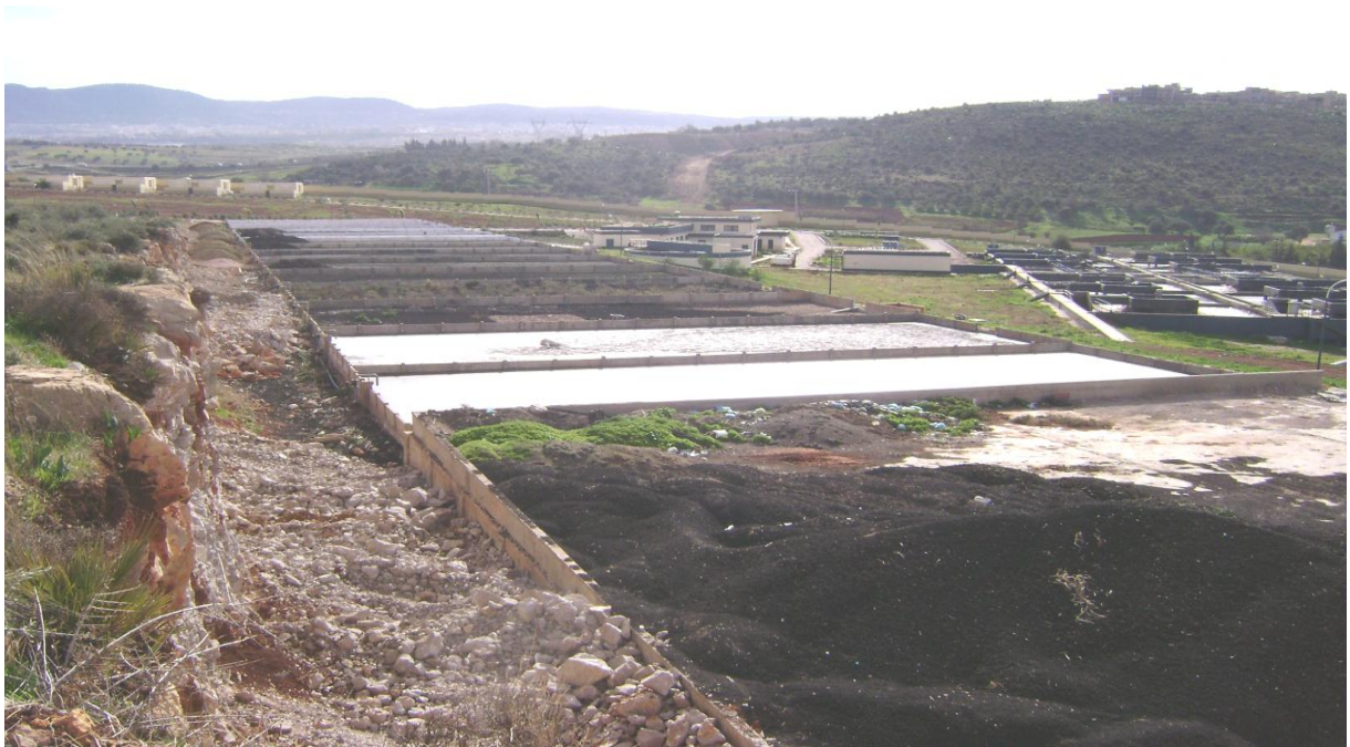
Figure 15 : Lits de séchage +Aire de stockage
