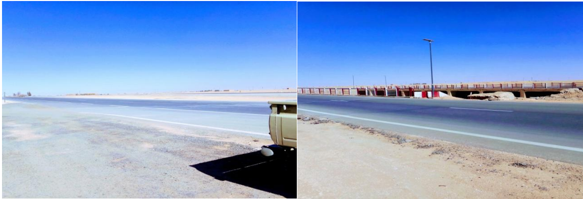
Photo n°27 : Accessibilité par la route nationale RN 06
