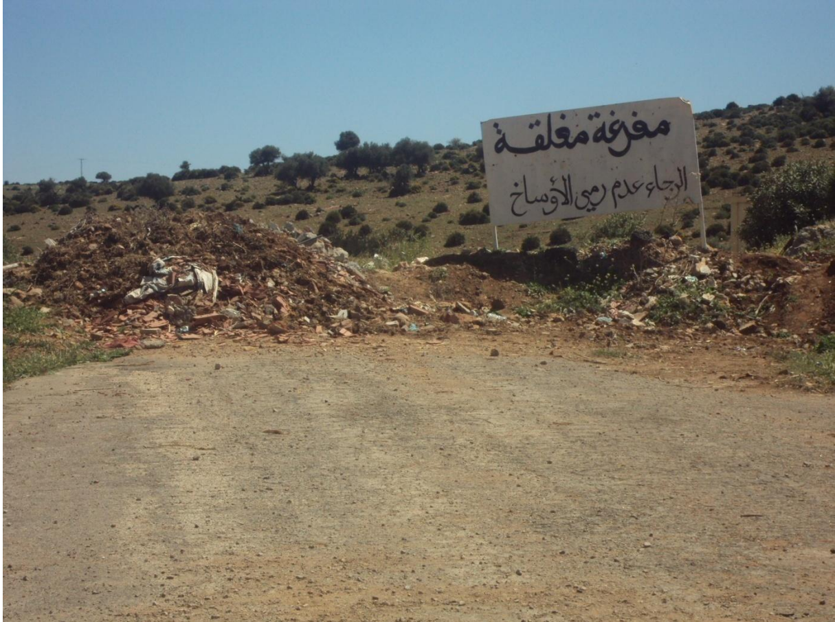
Photo n°4: Le site de la décharge d'Oued Lakhdar après fermeture
